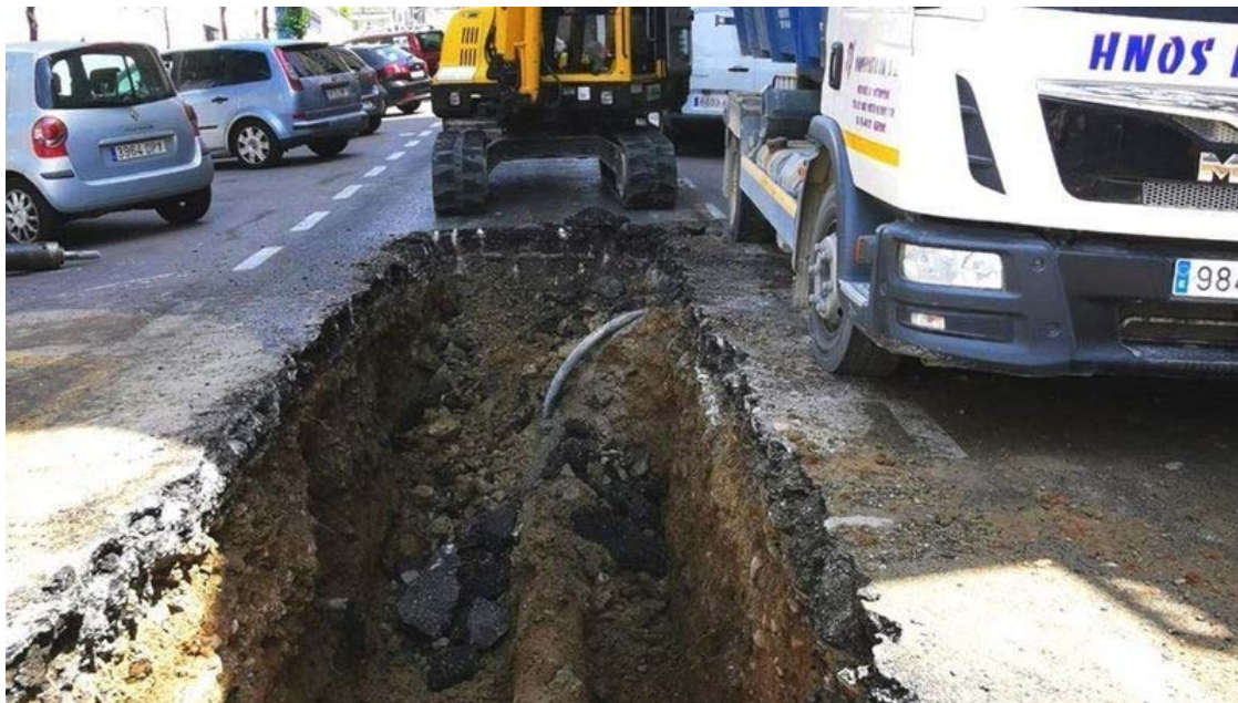
Obras en una tubería de Algeciras (ARCHIVO)
