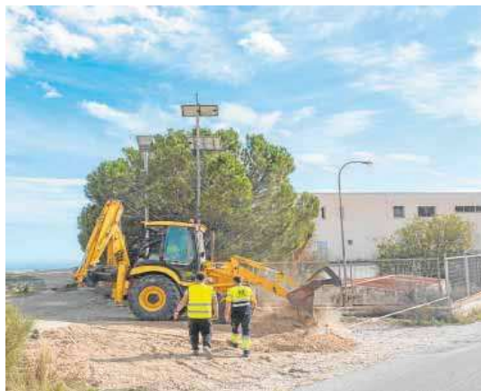
Comienzo de las esperadas obras de las canalizaciones. IDEAL
